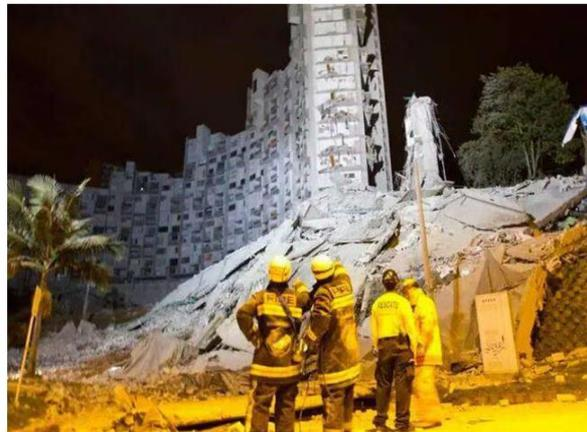
El 23 de septiembre de 2014 las cuatro torres cayeron tras un proceso de implosión, algo nunca antes visto en Colombia. Se utilizaron 200 kilos de explosivo Indugel y 3.000 metros de cordón detonante.
